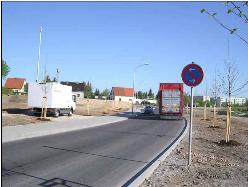
Abbildung 1: Blick auf die Straße „Am Schlachthof“ (Richtung Nordost) in Weißenfels
