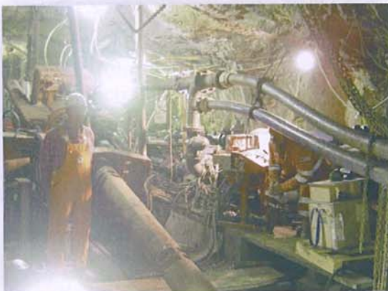
Vorbereitung der Flutung in der Grube "Einheit" bei Elbingerode
