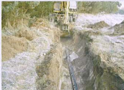
Rückbau Flowlines
