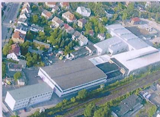
Sanierter innerstädtischer Produktionsstandort Dessau
