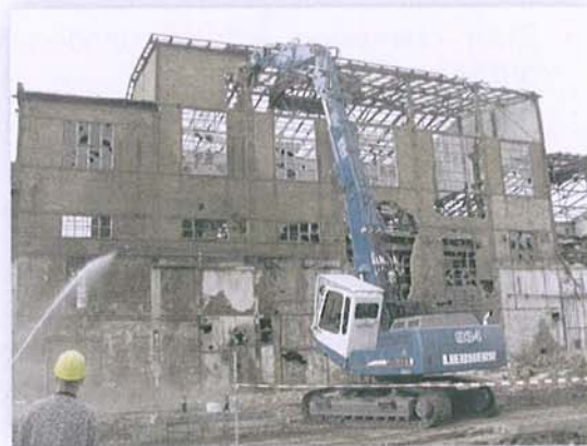
Rückbau der alten Lackfabrik
