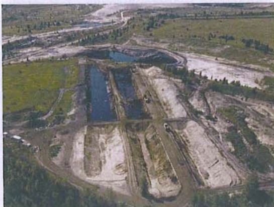
Sanierung von Säureharzbecken auf der Innenkippe Leonhardt
