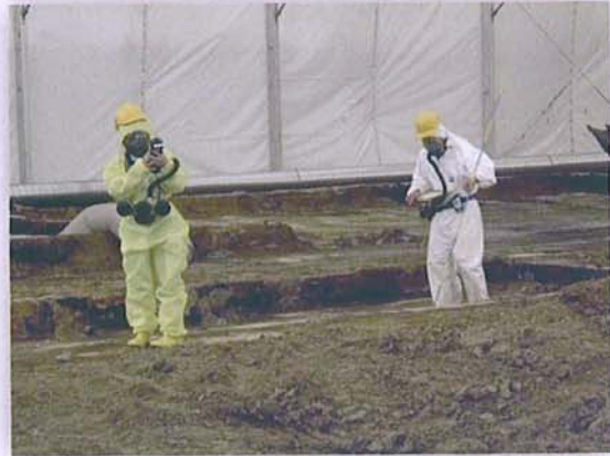
Bodensanierung unter Vollschutz
