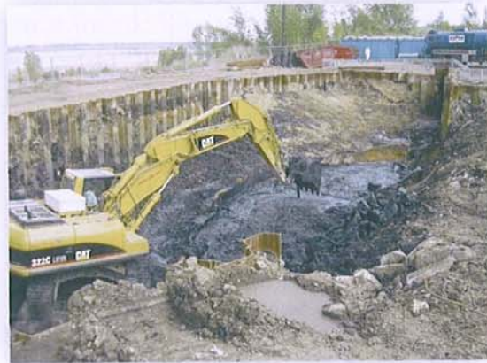
Sanierung Säureharzablagerungen auf dem Werksgelände
