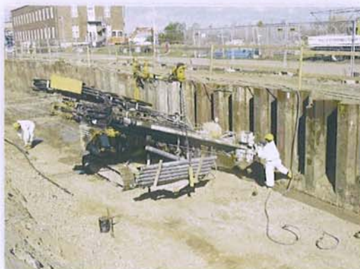
Vorbereitung Bodenaushub für Quellensanierung
