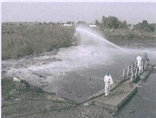
Emissionsreduzierung bei Teersee-sanierung
