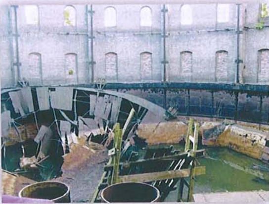
Bodensanierung im denkmalgeschützten Gasometer Halle
