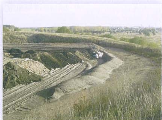
Deponie Griebö während der Sanierung
