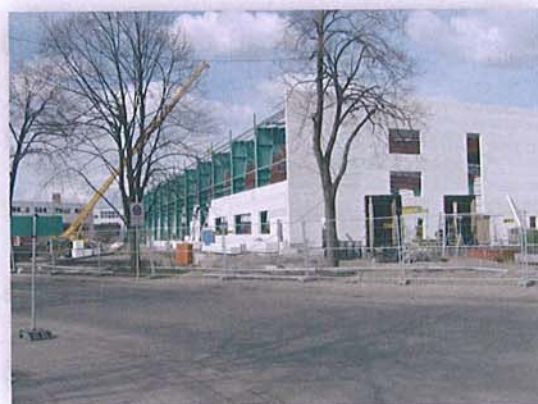
Neubau einer Industriehalle
