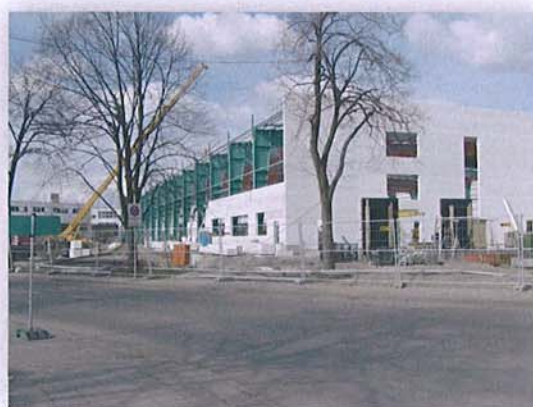
Neubau einer Industriehalle
