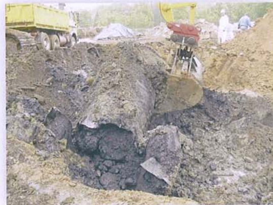
Bergung von Tanks
