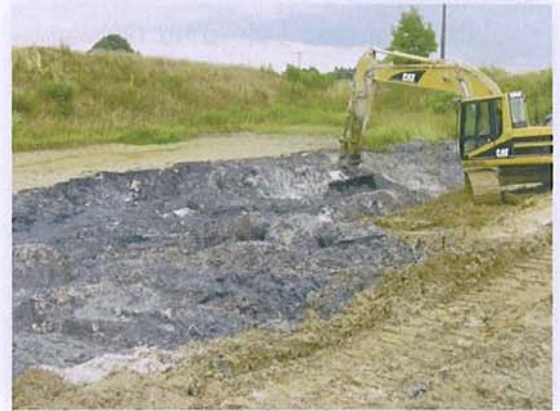
Auskoffern einer Bohrschlammgrube
