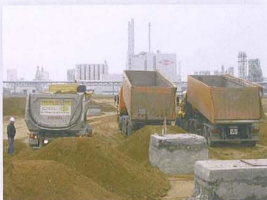
Sanierungsmaßnahmen in der Nachbarschaft neu gebauter Industrieanlagen
