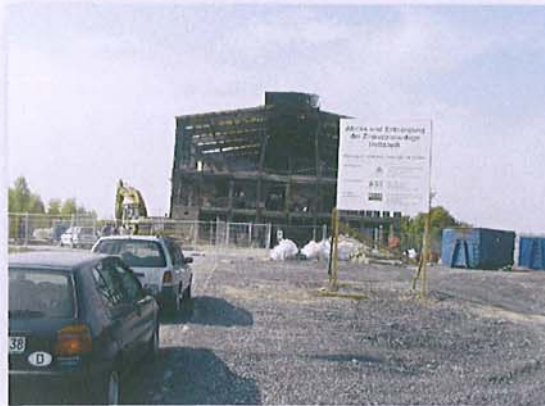
"Akropolis" in Hettstedt: Der Rückbau beginnt
