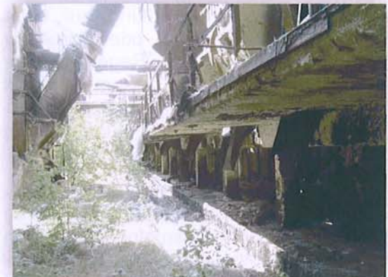
Gasgeneratorenanlage vor dem Rückbau
