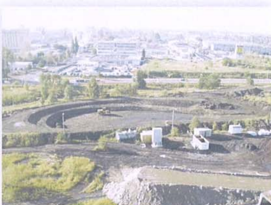
Teersee-sanierung, Vorbereitung der Wiederverfüllung
