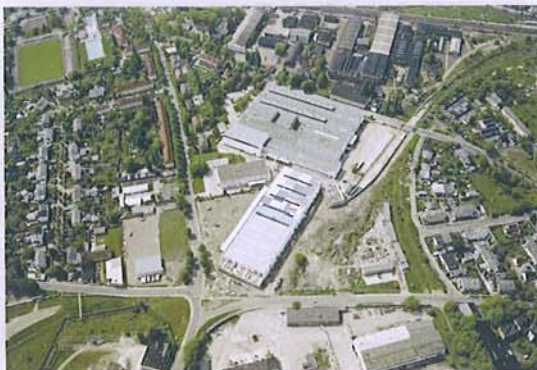
Produktionsstandort mit neu gebauter 1. Halle
