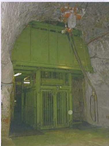
Neu gebauter Füllort Schacht Halle
