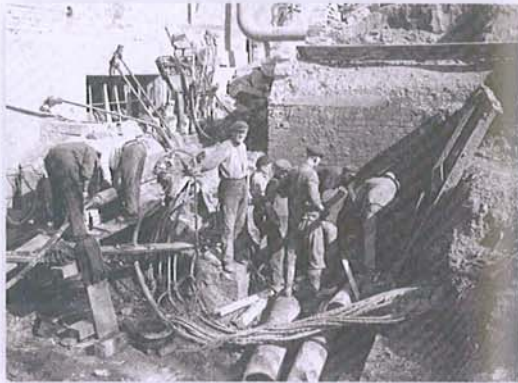
Reparaturarbeiten nach einem Luftangriff
