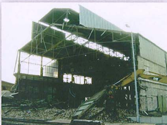
Rückbau dekontaminierter Gebäude
